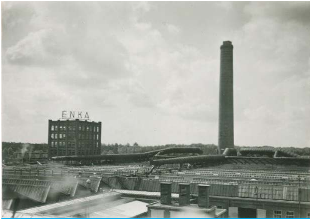
De centrale afzuiging in 1948 met de grote afzuigpijpen die over het terrein naar de grote schoorsteen lopen.
